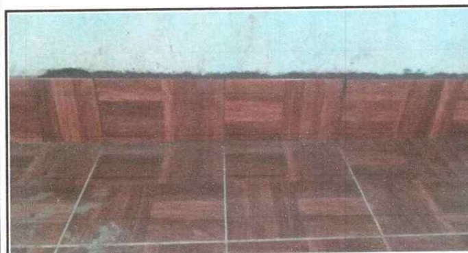
Foto 5: PISO Y SOCALO INSTALADO
